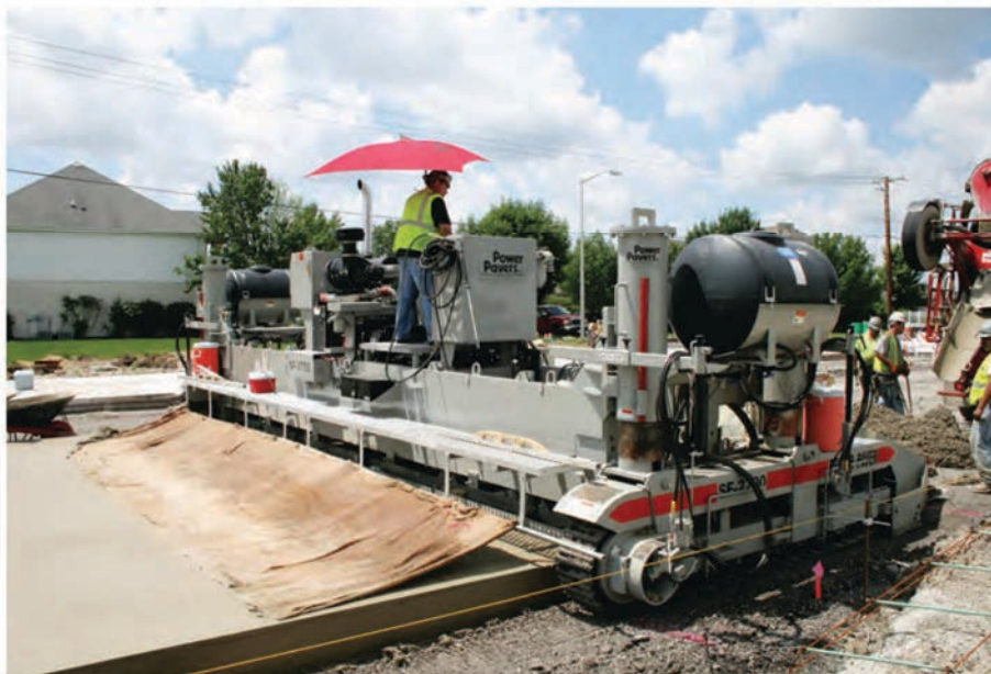
SF-2700 на укладке дорожного полотна. Крюки для крепления заглаживающей мешковины входят в базовую спецификацию.
