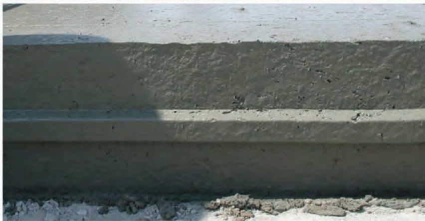
Боковой край полотна с соединением шип-паз .
