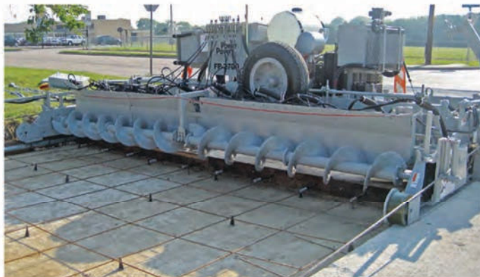
▲ рельсовые бетоноукладчики Power Pavers FP-2700 и FP-3000
