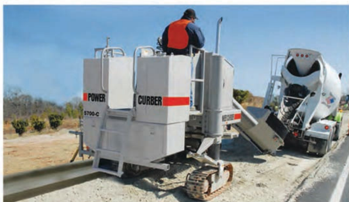
▲ бетоноукладчик монолитных профилей Power Curbers 5700-C
