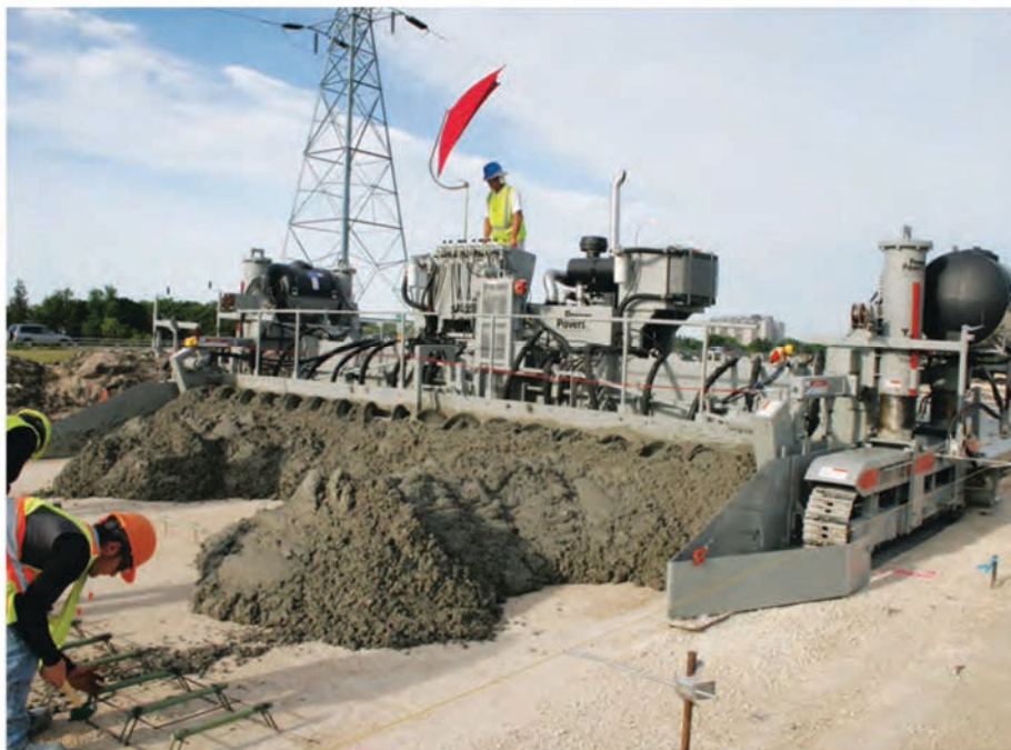
SF-2700 укладывает смесь поверх опорной конструкции продольных стержней.
