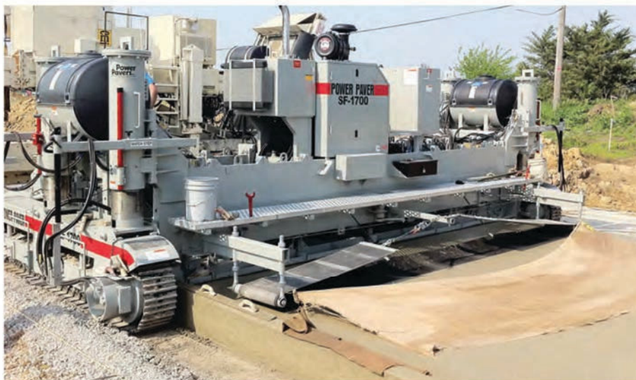
SF-1700 укладывает проезжую часть улицы с использованием интегрированного монолитного профиля. Для поверхностной обработки используются опциональные заглаживающая лента и заглаживающая мешковина
